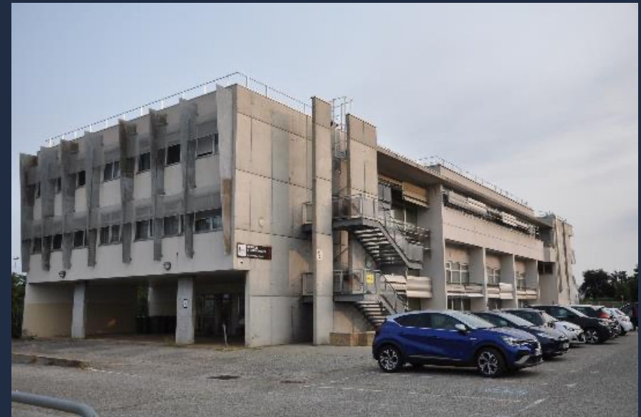
Briffaut B (entrée Sud)
